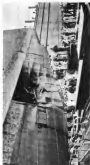
2. Torpedotreffer unterhalb des Panzers im Vordschiff eines Großen Kreuzers („Moltke“).
