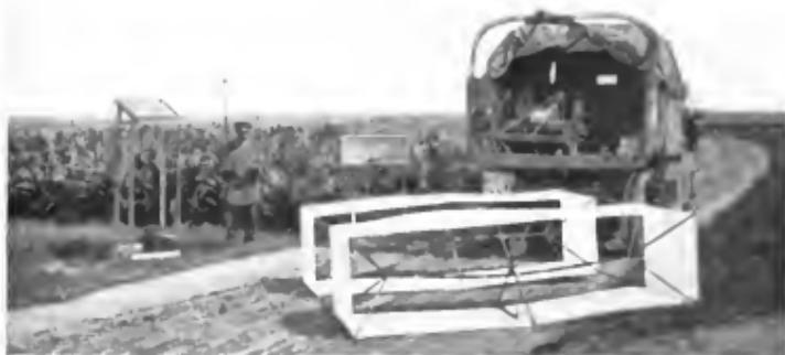
**3. Auf Lastwagen montierte Drachenwinde einer Drachenwarte und Kastendrachen.**
