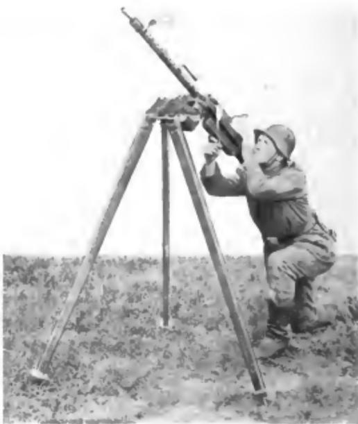
9. Deutsches Maschinengewehr 08/18 mit Kreisrohrvisier und Patronenkasten 16 auf Kolonnen-Dreifuß mit Hilfslafette.
