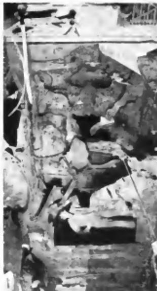
4. Trefferwirkung einer 34,2-cm-Panzergranate auf die Borbetondeck zwischen Panzerdeck u. Batteriedeck eines Gr. Kreuzers („v. S. Tamm“).
